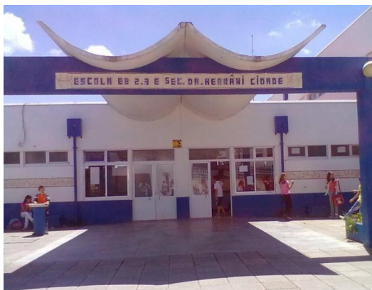
FIGURA 14 - ENTRADA PRINCIPAL DA ESCOLA
